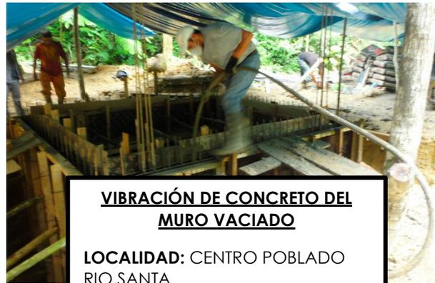
**VIBRACIÓN DE CONCRETO DEL MURO VACIADO**
